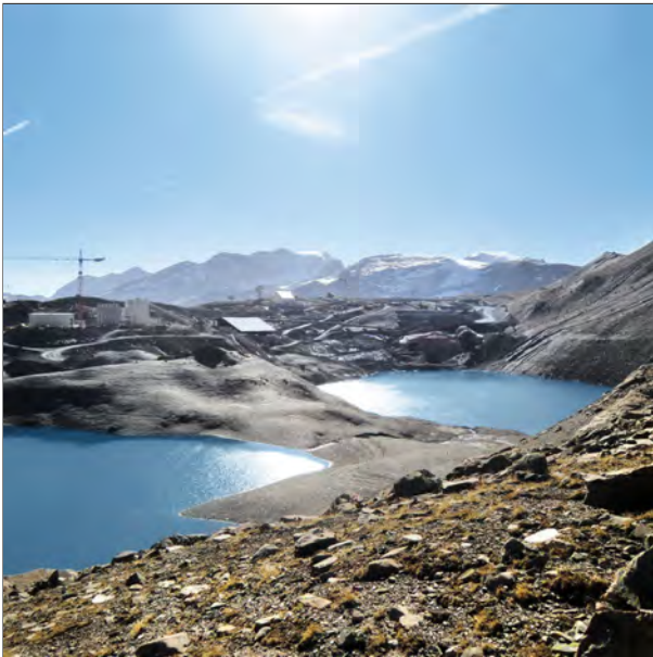
Beispiel Pumpspeicherwerk - die Füllstandmesstechnik gibt Raum für alternative Energiekonzepte. (Bild: Vega)
