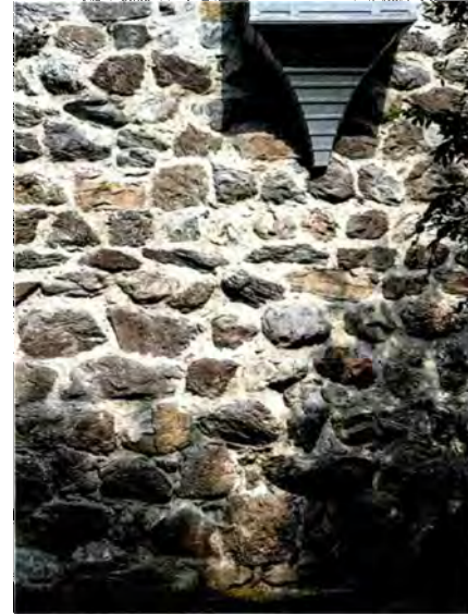
Mauerwerk aus grossformatigen, grob zugerichteten Verrucano-Rohblöcken am historischen Hardtum in Zürich.
