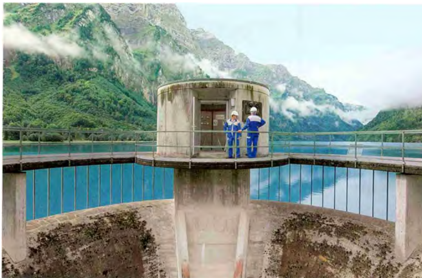
Das Kraftwerk am Löntsch erzeugt mit dem Wasser des Klöntalersees jährlich rund 120 GWh.
