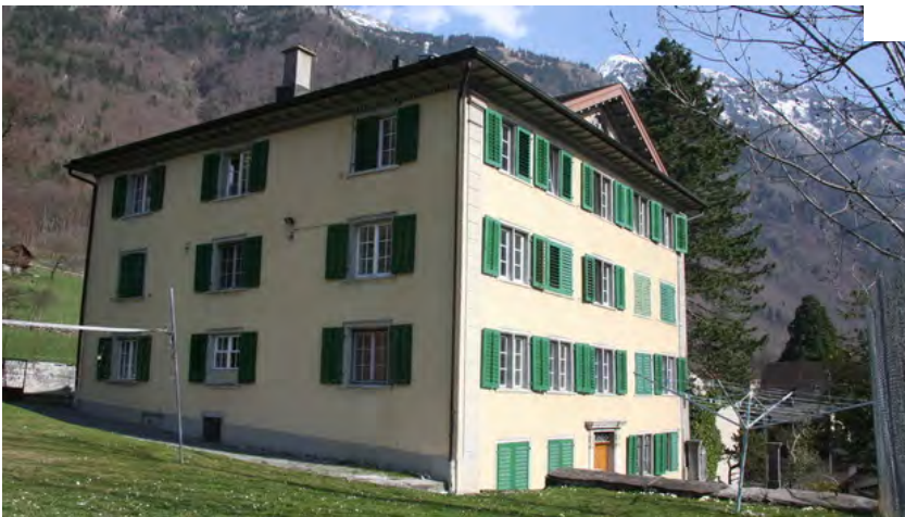
Das Durchgangszentrum Rain soll in sechs Etappen saniert werden. ZVG
