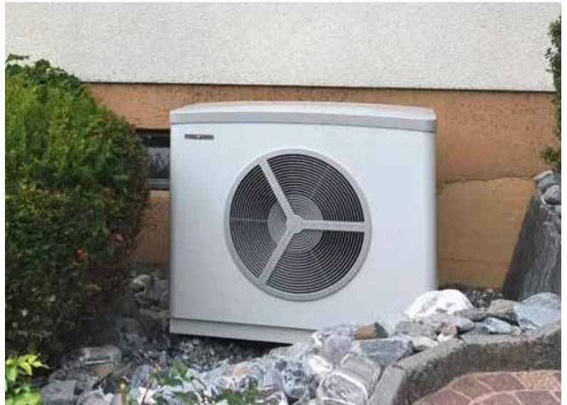
Bei Luft/Wasser-Wärmepumpen muss der Lärmbekämpfung grosse Aufmerksamkeit geschenkt werden
