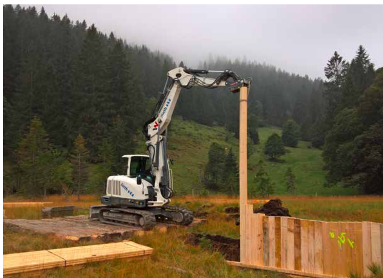
Platzieren einer zusätzlichen Holzbohle an die bereits eingedrückten Holzbohlen mit Kleinbagger
