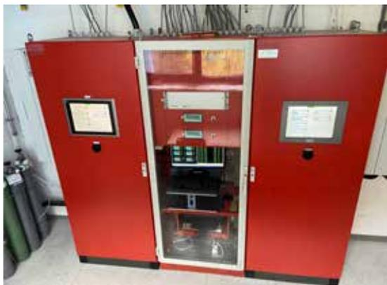
Messgerät für die Kontrolle von Schwermetallen im Abwasser (AUE).
