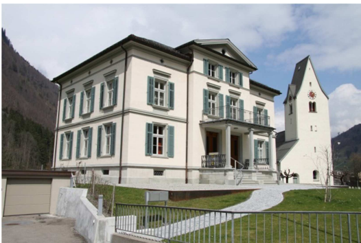
Betschwanden, Reformiertes Kirchenzentrum
