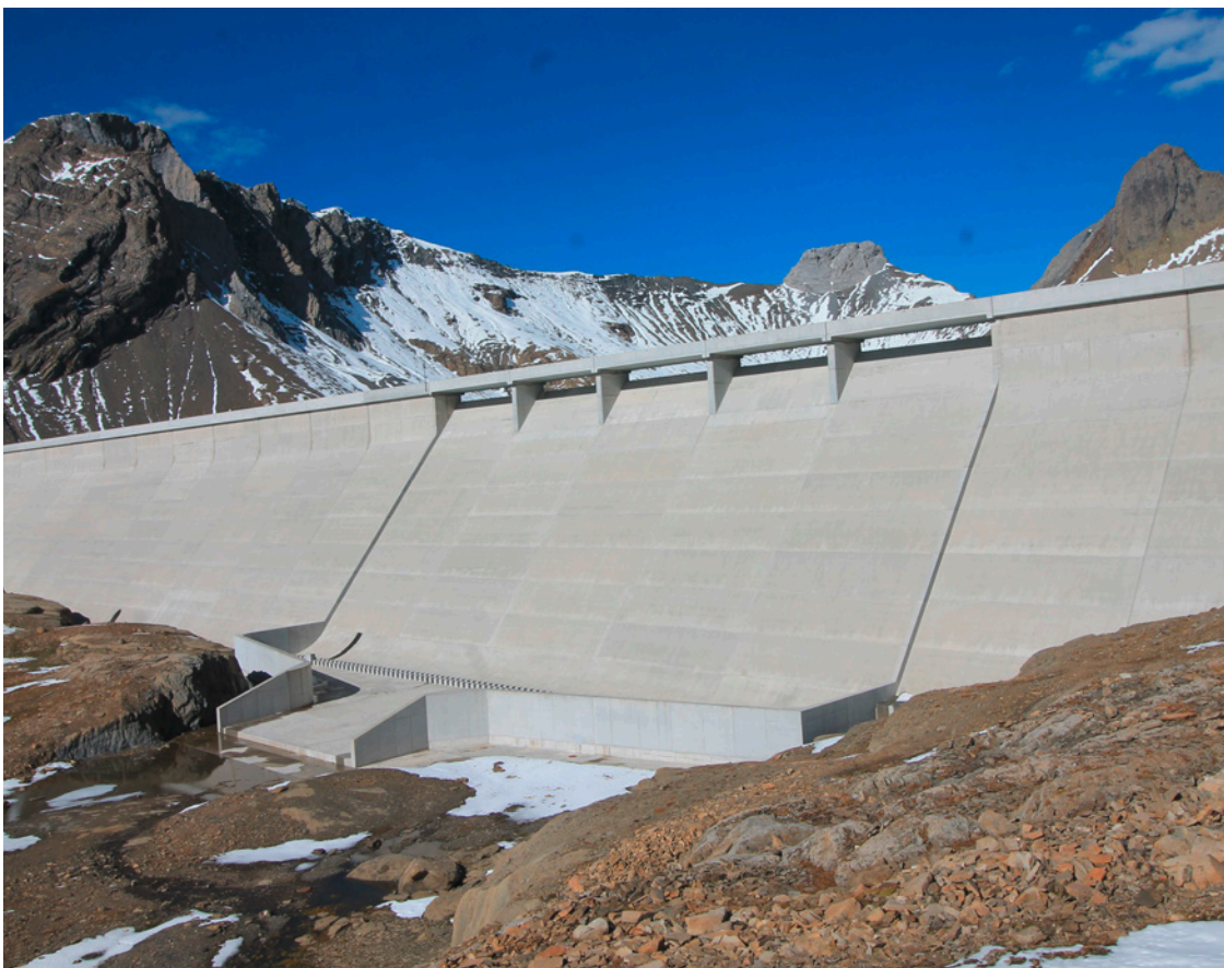
Auf der Staumauer Muttsee soll eine grosse Photovoltaikanlage mit einer Leistung von 2 MW erstellt werden. (AUE).
