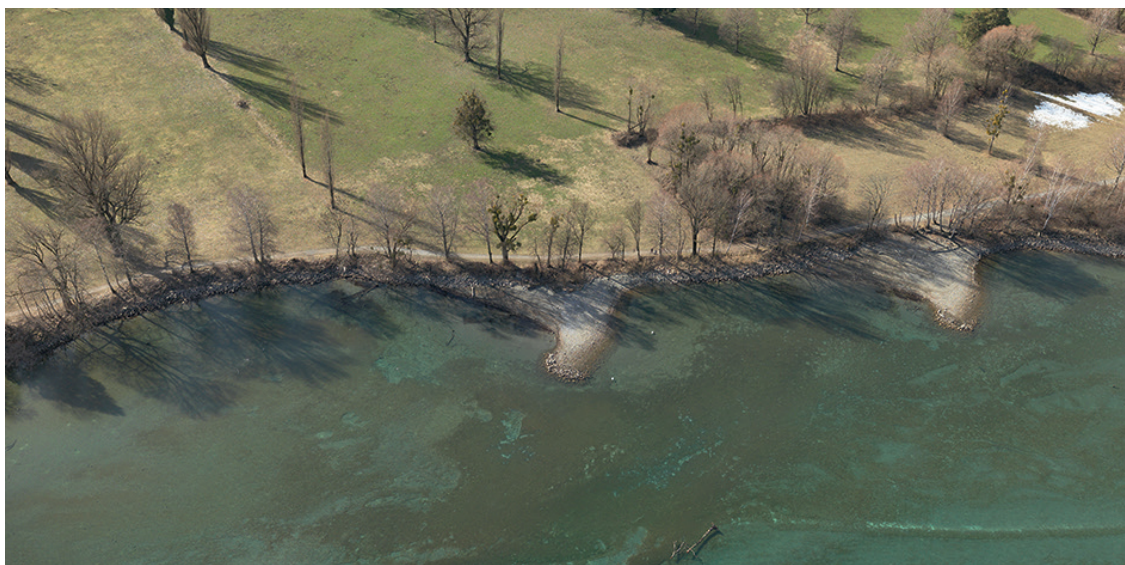
Seeufer des Walensees im Huttenbösch mit Seestrukturen (AUE)
