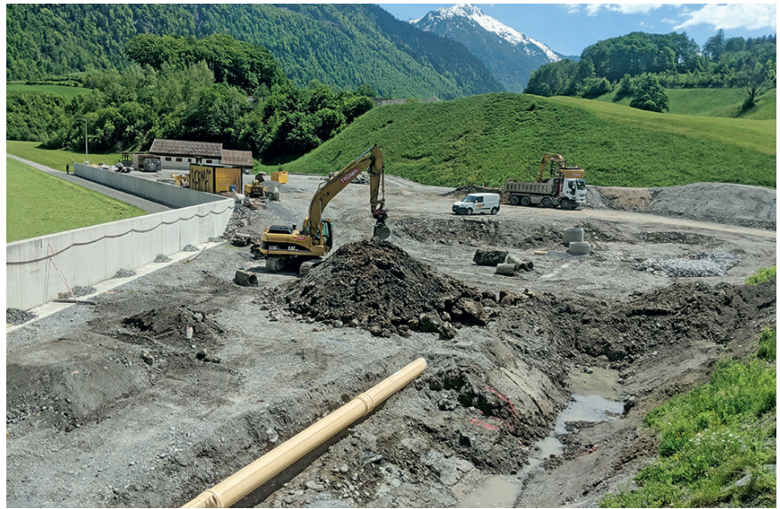
Sanierung im August 2018 (AUE).
