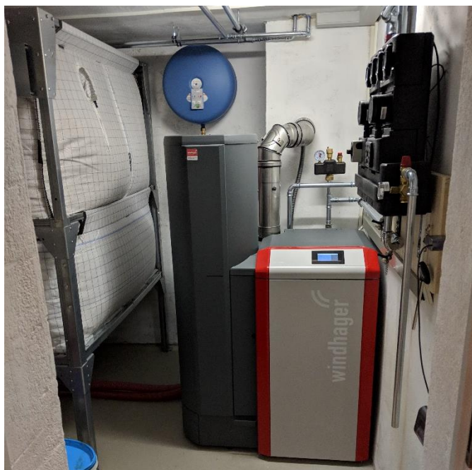
Abbildung 6: Pellet Feuerung in einem EFH realisiert 2018
