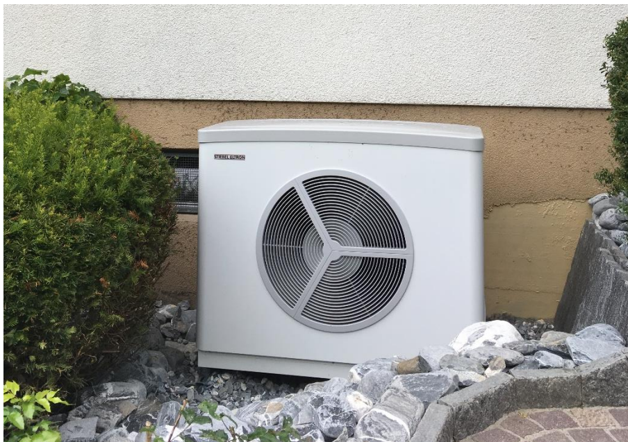
Abbildung 7: Geförderte Luft/Wasser Wärmepumpe
