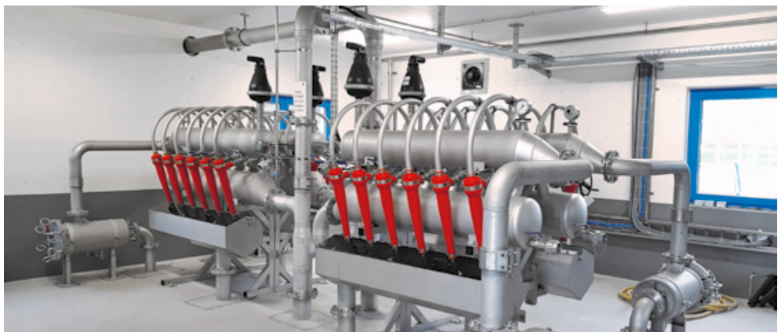
Zyklone zur Abscheidung der Granulen im S::Select-Verfahren. (Foto: Alain Meyer, HBT)
