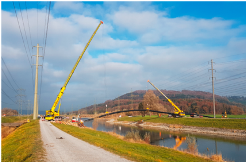
Verlegearbeiten der neuen Revisionsleitung über die Linth für den späteren Kläranlagenauslauf mit einer Unterführung unter die Autobahn. (Foto: Alain Meyer, HBT)
