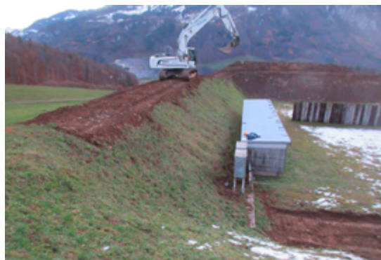
Altlasten-Sanierung der Schiessanlage Allmeind in Glarus
